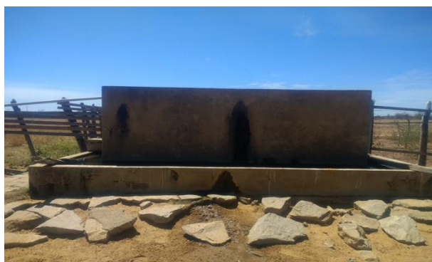
Figura 8 - Reservatório destinado aos animais.
