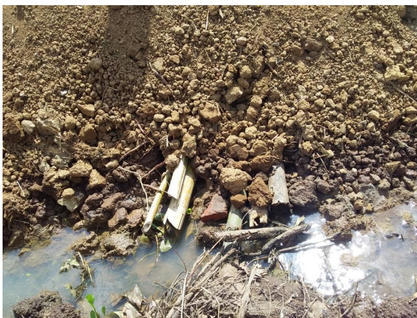
Figura 17 - Drenagem realizado utilizando-se colmos de bambu.
