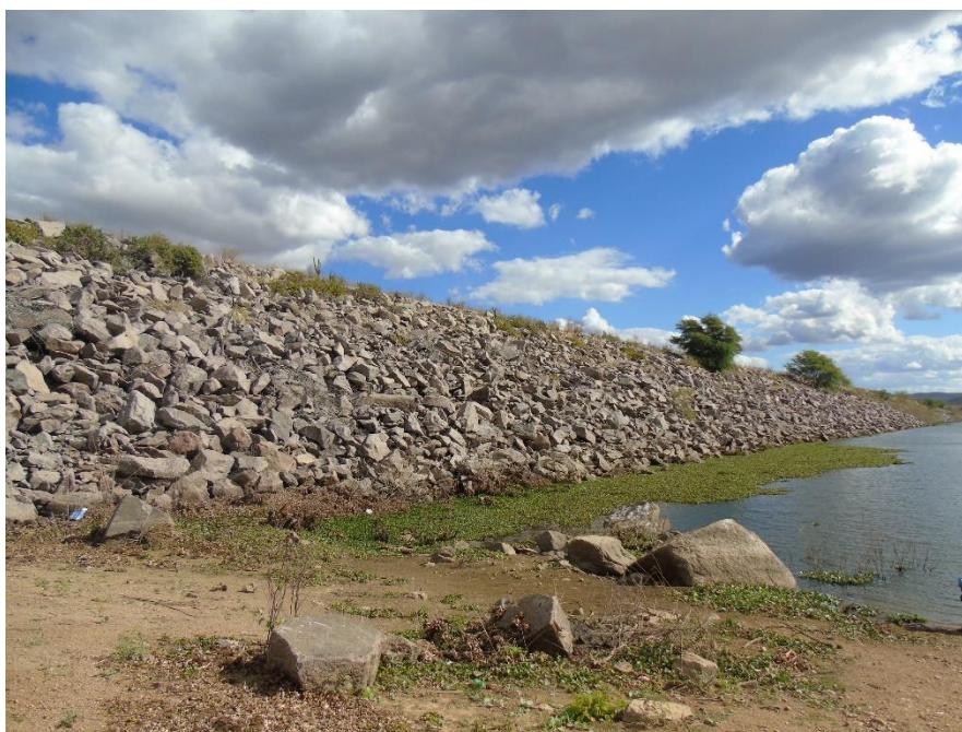
Figura 13. Parede principal a montante da barragem de Serrinha II
