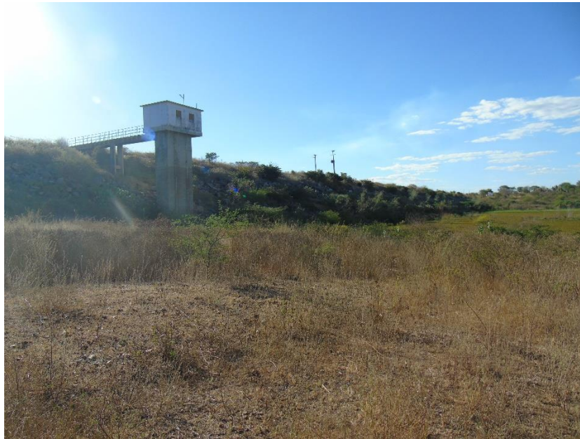
Figura 06. Presença de vegetação densa na parede principal da barragem do Rosário
