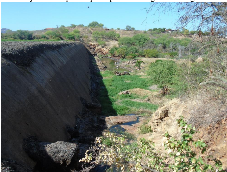
Figura 09. Presença de vegetação, infiltração, água parada a jusante da parede principal da Barragem do Jazigo.
