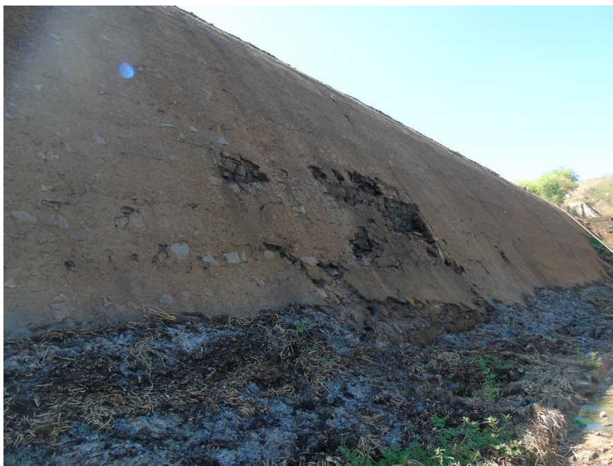
Figura 10. Rachaduras no talude a jusante da barragem do Jazigo
