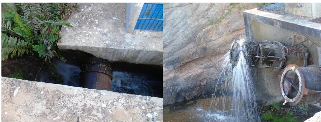
Figura 14. Comportas da barragem de Serrinha II
