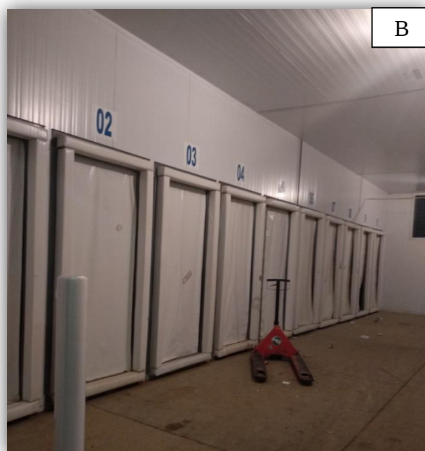
Figura 25- Câmara fria com paletes (A) e túneis de resfriamento (B).
