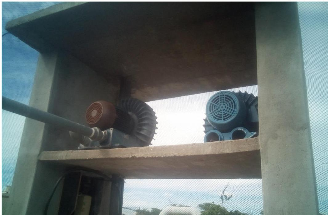
**Figura 10.** Compressor usado na aeração dos tanques de cultivo do alevino 2 da empresa AAT International
