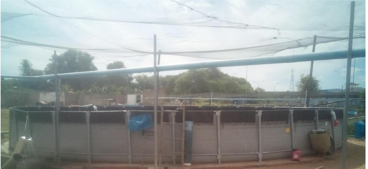
**Figura 9.** Tanque circular de geomembrana usado no setor alevino 2 na empresa AAT International
