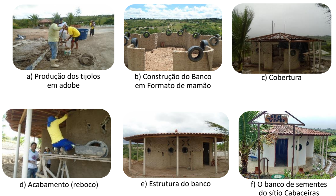
Figura 6. Processo de construção do BSC do Sítio Cabaceiras, Canhotinho-PE, 6 a) Produção dos tijolos em adobe, 6 b) Construção do banco, 6 c) Cobertura, 6 d) Acabamento (reboco), 6 e) Estrutura do banco, 6 f) O banco de sementes do sítio Cabaceiras. Fonte: Elaborado pelo autor (2019).
