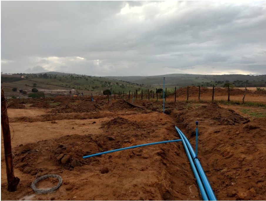
Figura 14 - Colocação da tubulação do ramal principal.
