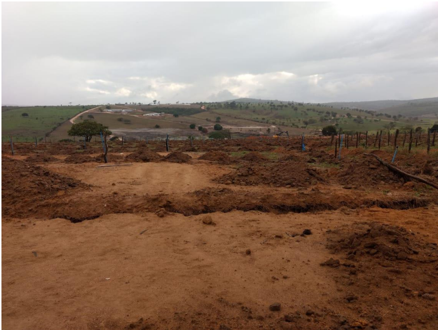
Figura 6 - Vista de cortes no solo para instalação dos tubos dos ramais principais e ramais de serviço. Solo classificado como textura média.
