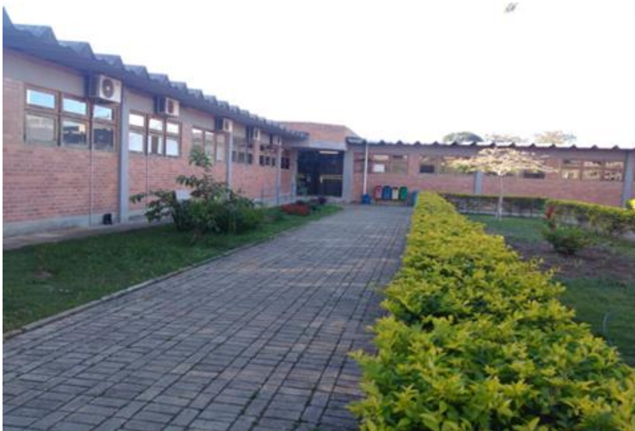
Figura 4. Entrada do Centro Laboratorial de Apoio à Pesquisa da Unidade Acadêmica de Garanhuns (Arquivo Pessoal).
