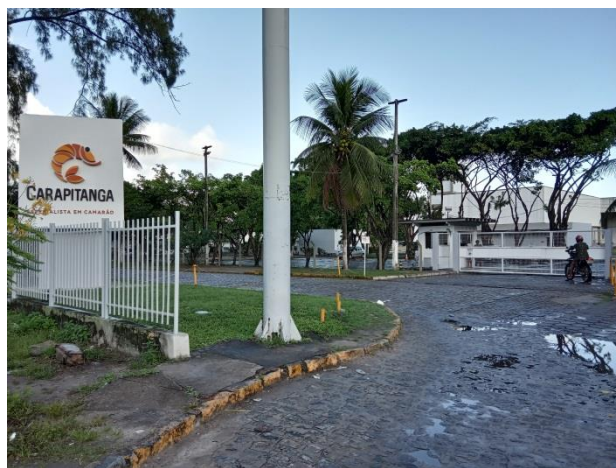
Fig. 2 – Acesso das edificações da Carapitanga.
