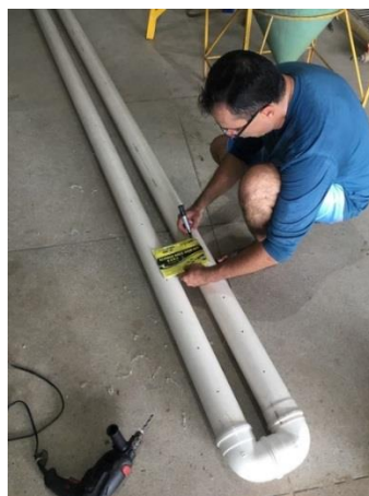
Figura 34. Junção dos canos de 100mm com o joelho. Fonte: Acervo pessoal, 2019.
