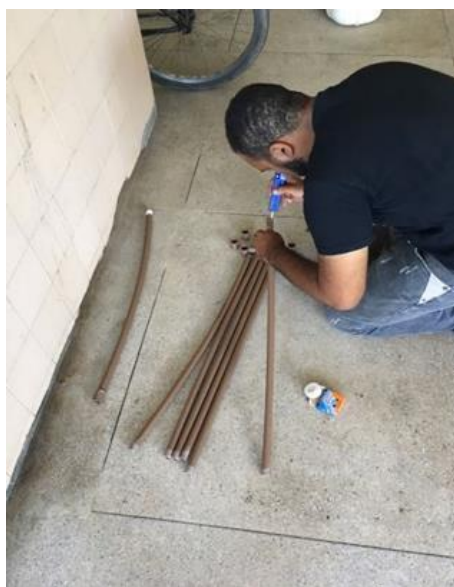
Figura 38. Colagem do cano de 20mm.
