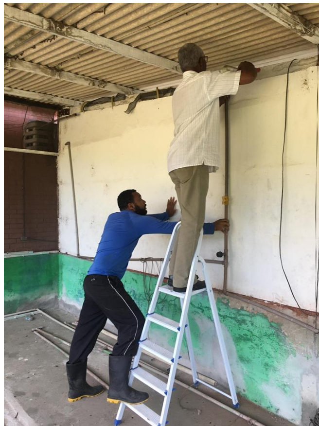
Figura 26. Inserção de pontos de água e ar. Fonte: Acervo pessoal, 2019.
