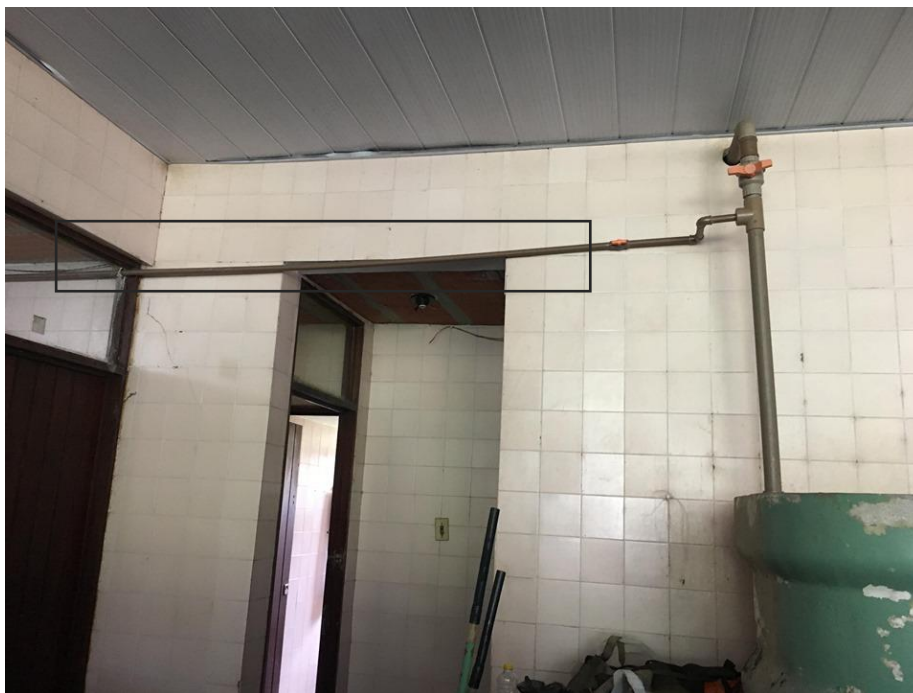
Figura 17. Sistema de passagem de água pós-reforma. Fonte: Acervo pessoal, 2019.
