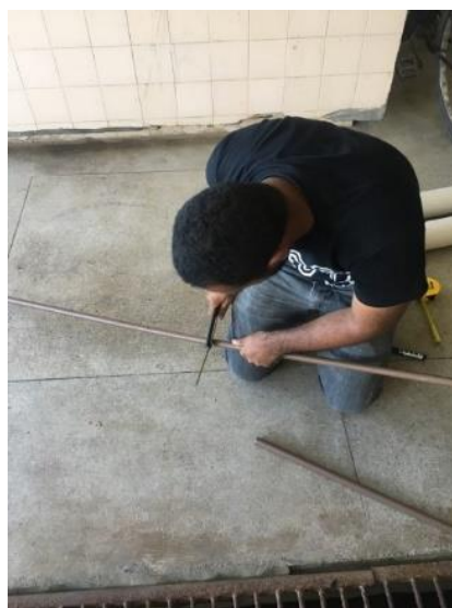
Figura 36. Corte dos canos de 20mm. Fonte: Acervo pessoal, 2019.
