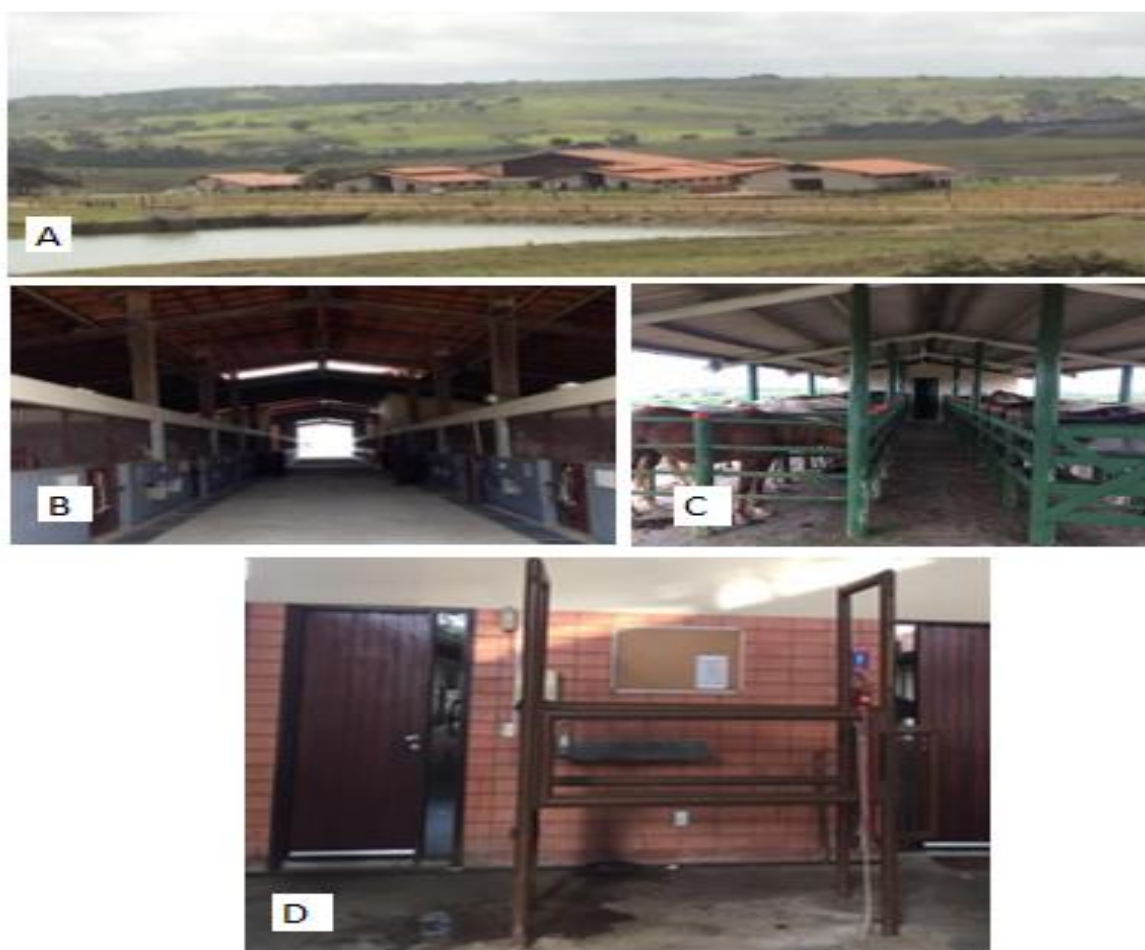
Figura 1. Instalações do Haras Monte Verde: Vista panorâmica (A); Pavilhão de baias (B); Lanchonete (C); Brete de contenção (D); (Fonte: Arquivo Pessoal, 2019).
