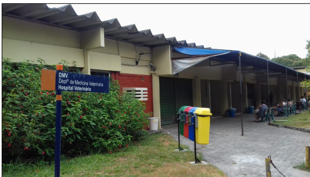
Figura 1. Hospital veterinário da UFRPE
