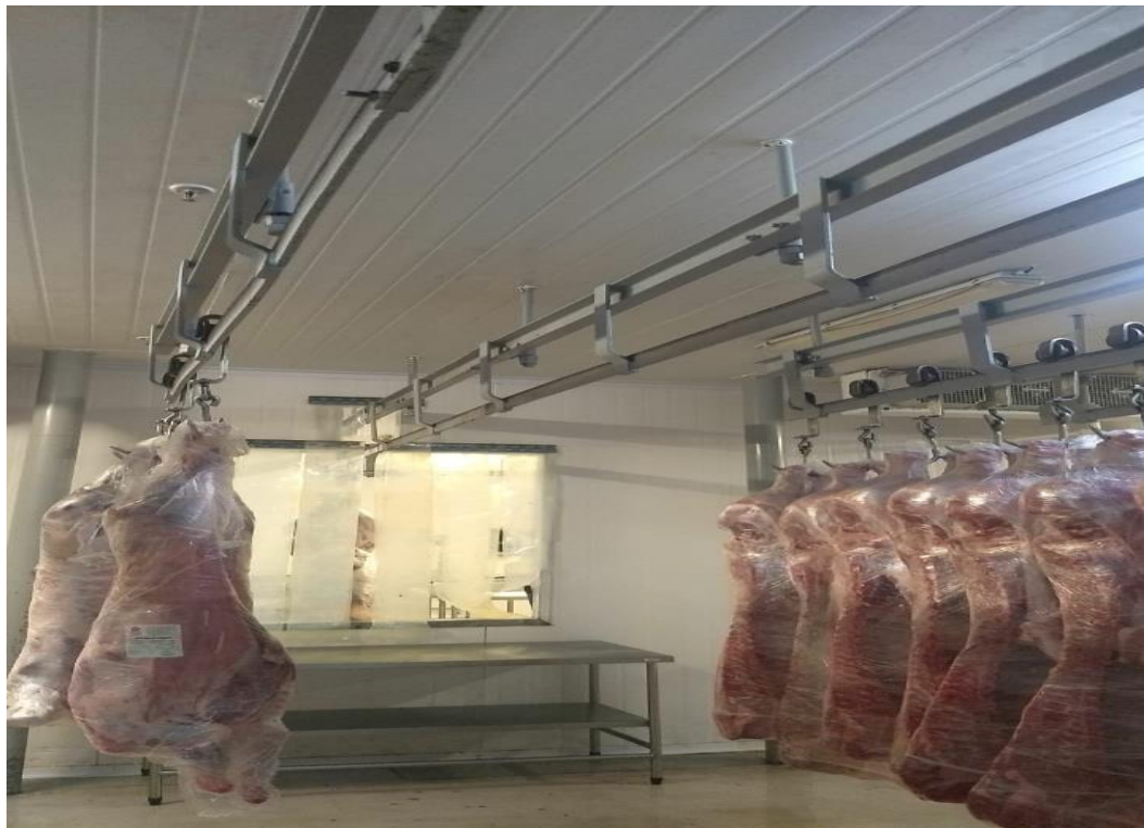
10 Figura 7. Câmara resfriada para armazenamento de carcaças com óculo de acesso a área de 11 manipulação, localizada em hipermercado visitado durante a realização do ESO do período de 12 12 de agosto a 18 de novembro de 2019.
