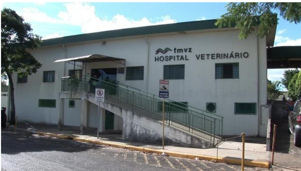
Figura 2. Fachada do Hospital Veterinário da Universidade Estadual Paulista “Júlio de Mesquita Filho” - Faculdade de Medicina Veterinária e Zootecnia (FMVZ), em Botucatu-SP.
