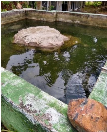
Figura 15 - Tanque das tartarugas no CETAS-PE
