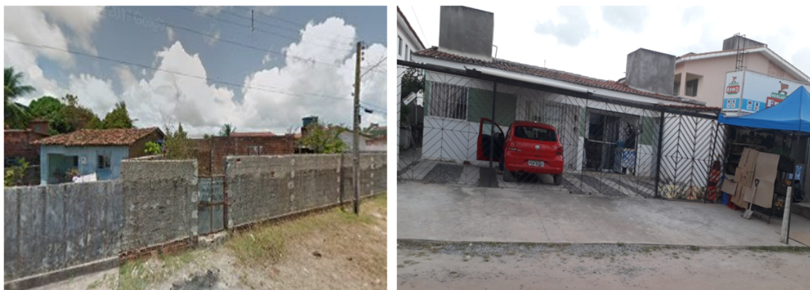
Figura 6 - Terreno antes e depois da construção
