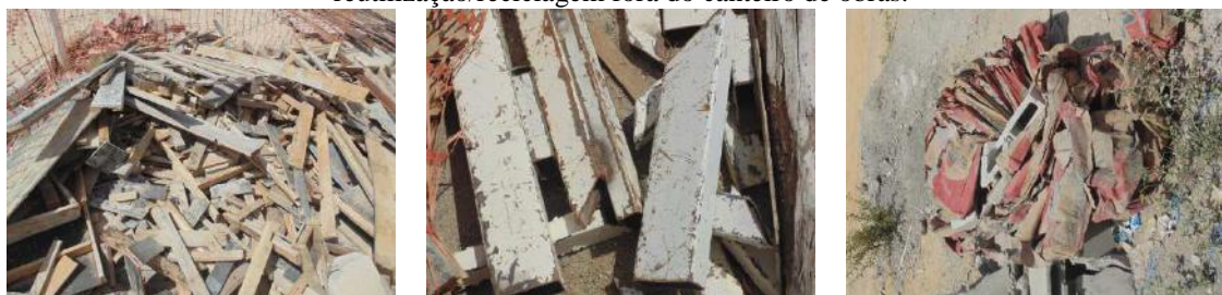
Figura 3. Resíduos sólidos da Classe B (madeiras, ferragens e papéis/papelão) segregados para destinações de reutilização/reciclagem fora do canteiro de obras.
