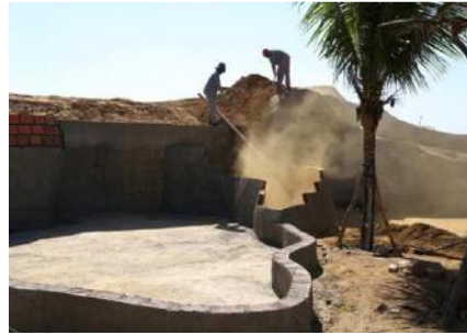
Figura 8. Reaproveitamento de resíduos Classe A para construção de uma cascata.
