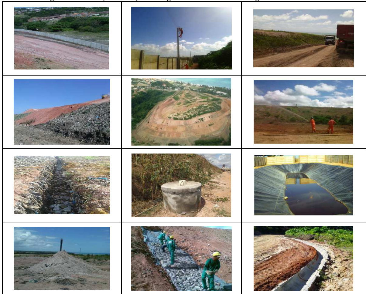
Figura 10. Ilustrações das ações emergenciais executadas no antigo vazadouro de Maceió.
