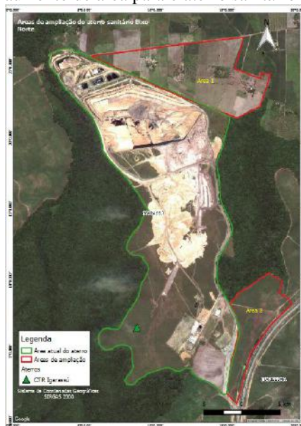
Figura 6. Proposta de aumento de área para o aterro sanitário em Igarassu – Opção 1
