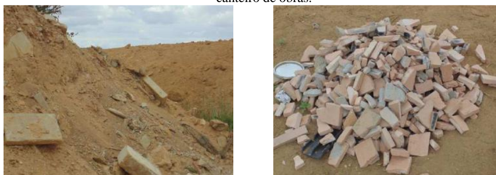
Figura 2. Resíduos sólidos da Classe A (solo, materiais cerâmicos) segregados para reaproveitamento no próprio canteiro de obras.
