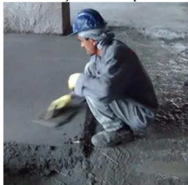
Figura 2. Execução de contrapiso cimentado.
