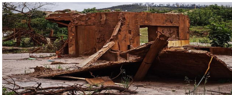
Figura 1: Danos do rompimento da barragem de Mariana
