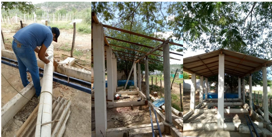
Figura 2- Atividade de recuperação do galpão do setor de avicultura da EAI
