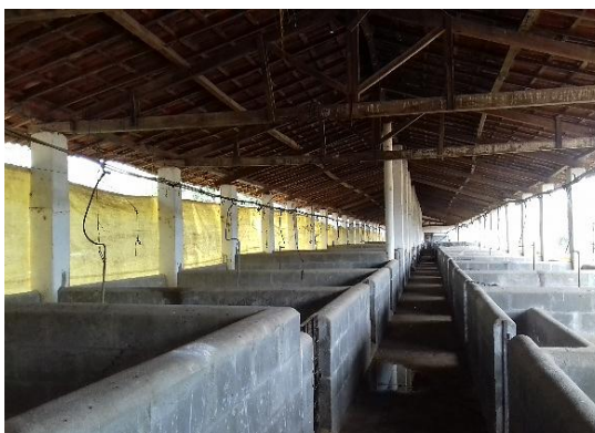
FIGURA 11: Antigo galpão avícola após reforma para criação de suínos (Arquivo pessoal).
