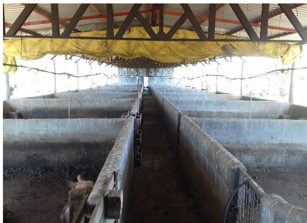
FIGURA 12: Galpão construído para engorda e terminação de suínos (Arquivo pessoal).
