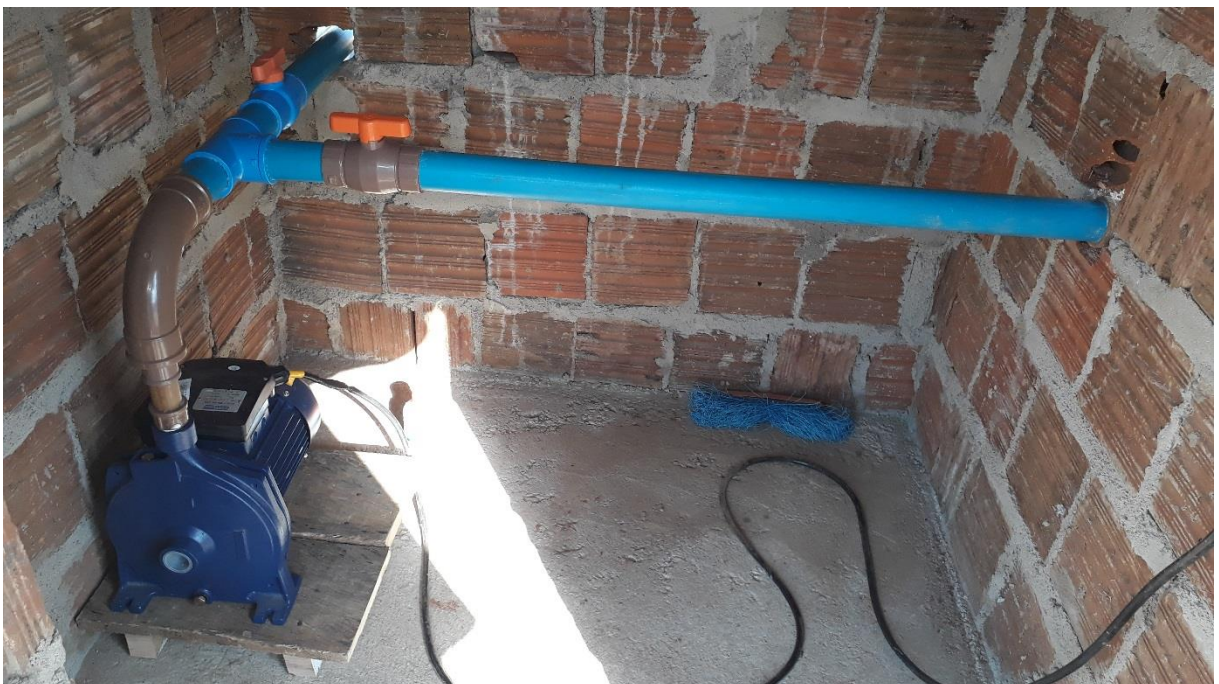
Figura 27. Conexões para sistema de retorno.
