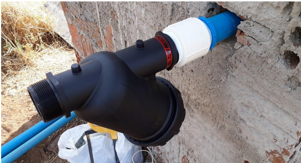
Figura 28. Instalação de filtro de proteção.
