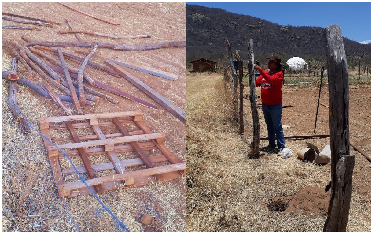
Figura 10. Cercamento da área (A esquerda estacas utilizadas, e a direita fixação de tela).
