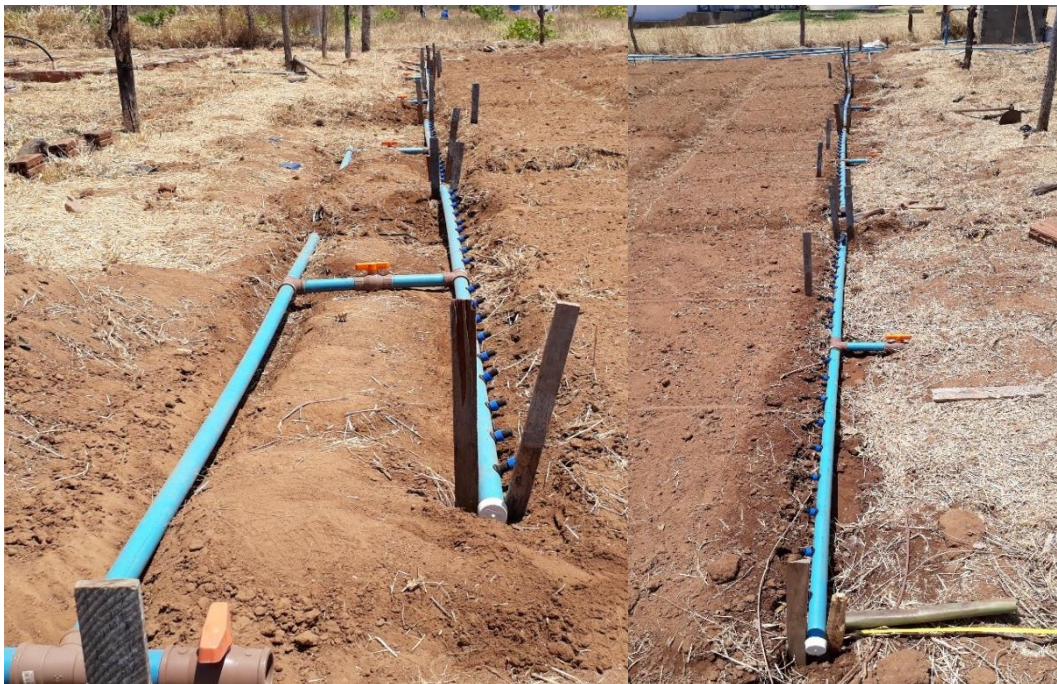
Figura 29. Instalação tubulação linhas lateral e ramais.
