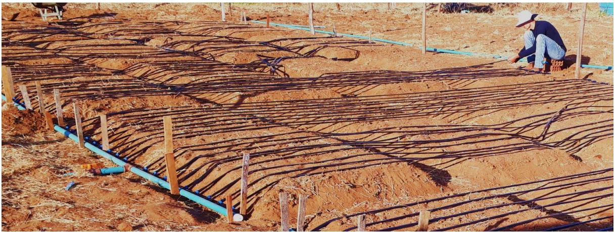
Figura 30. Instalação de fitas de gotejo.
