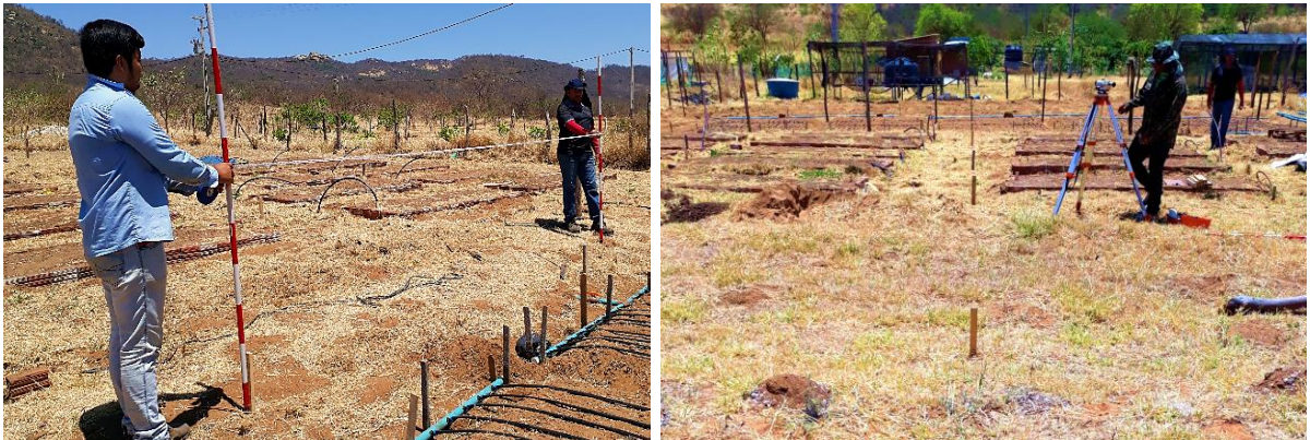
Figura 19. Identificação dos pontos (A esquerda demarcação dos pontos para fixação dos piquetes, a direita piquetes já fixados).
