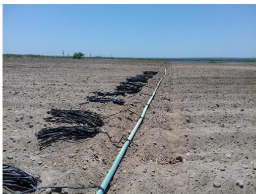
Figura 1. Início da montagem
