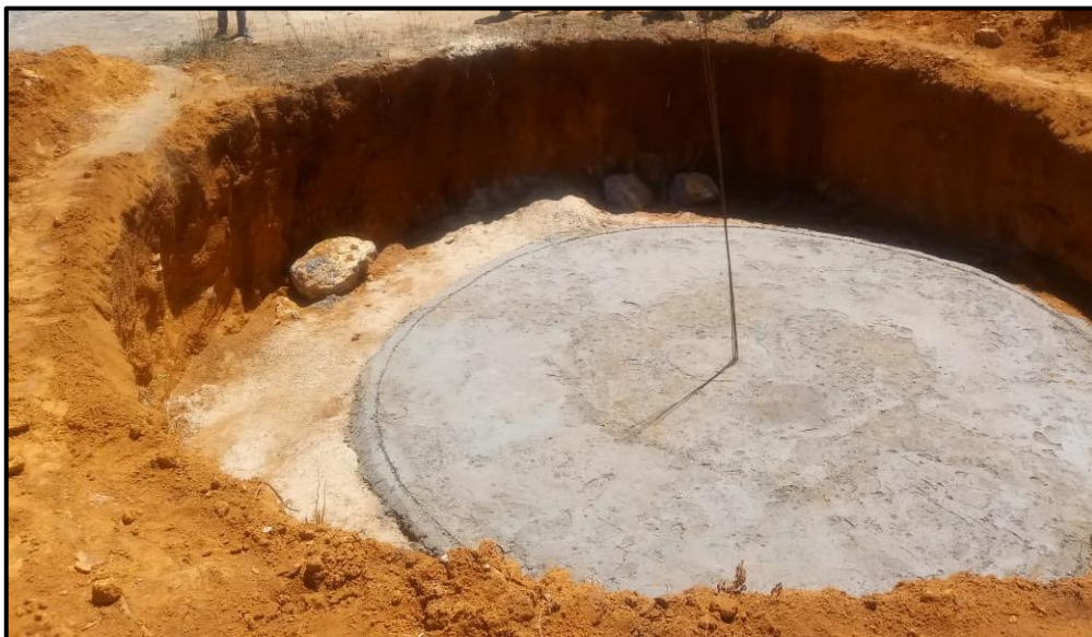
Figura 10. Acompanhamento do dimensionamento e escavação da cisterna calçadão. Fonte: IPA (2019).
