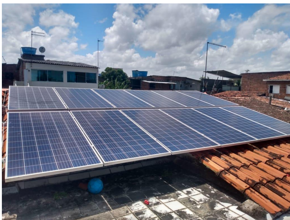
Figura 24 - Módulos após limpeza com água.
