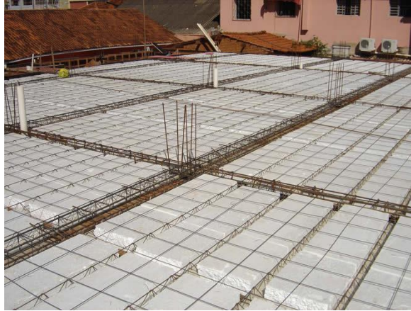
Figura 2 - Laje nervurada pré-moldada com preenchimento de EPS. FONTE: Protend, 2019.
