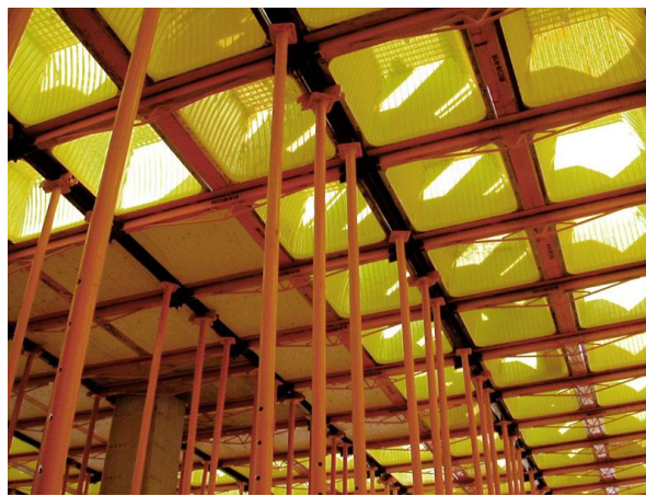
Figura 5 - Laje nervurada moldada "in loco" com utilização de fôrmas em cubeta vista de baixo. FONTE: ULMA locações, 2019.
