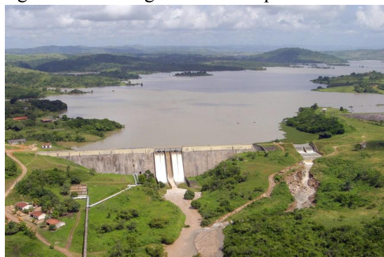
Figura 06 – Barragem do Rio Tapacurá
