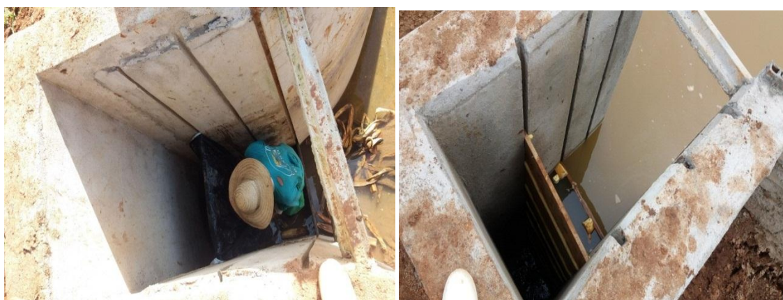
Figura 3. Comporta de drenagem tipo “monge”. (A) Colocação das tábuas de vedação utilizada para manutenção do nível dos viveiros e drenagem de água. (B) Viveiro preenchido com água.
