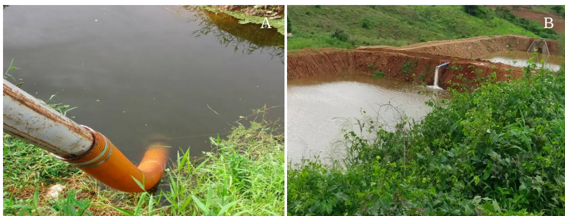
Figura 5. Abastecimentos dos viveiros. A - Local de captação da água no açude Araçagi, com mangote de sucção para o captação de água. B – Vista do sistema de abastecimento por tubulações.
