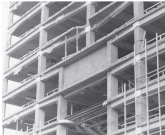
Figura 1: Viga parede com vão
