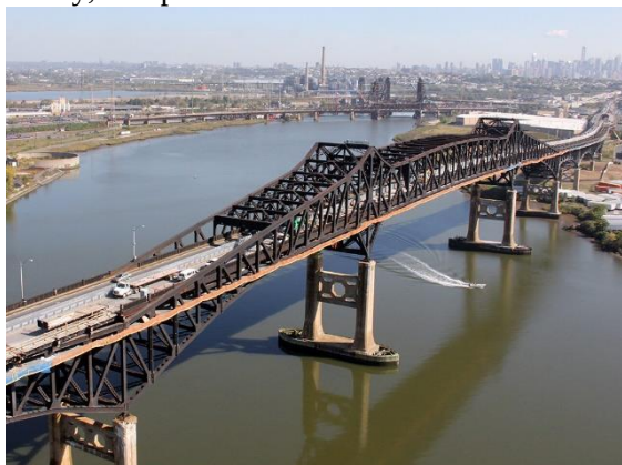
Figura 20 – Ponte Gen. Pulaski Skyway, Nova Jersey, recuperada com CUAD
