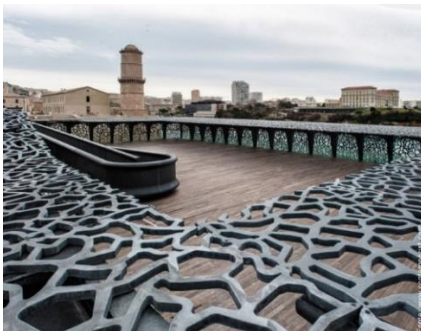
Figura 18 – Detalhe de disposição dos painéis em concreto. Museu das Civilizações Europeias e Mediterrâneas.
