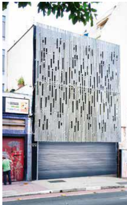
Figura 22 – Ministério das Relações Exteriores após revitalização de fachada utilizando painéis em CUAD.
