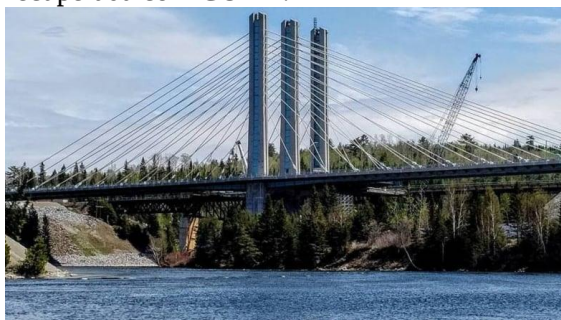
Figura 21 – Ponte do Rio Nipigon, Ontário, recuperada com CUAD.
