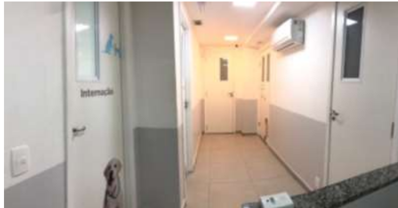
Figura 10 - Corredor principal do segundo andar. Fonte: Arquivo pessoal, 2021.
