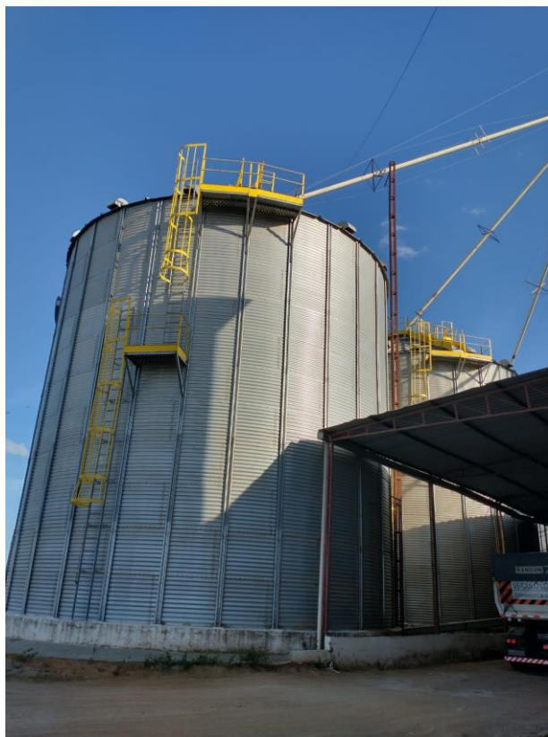
Figura 39. Silo da fábrica de ração.
