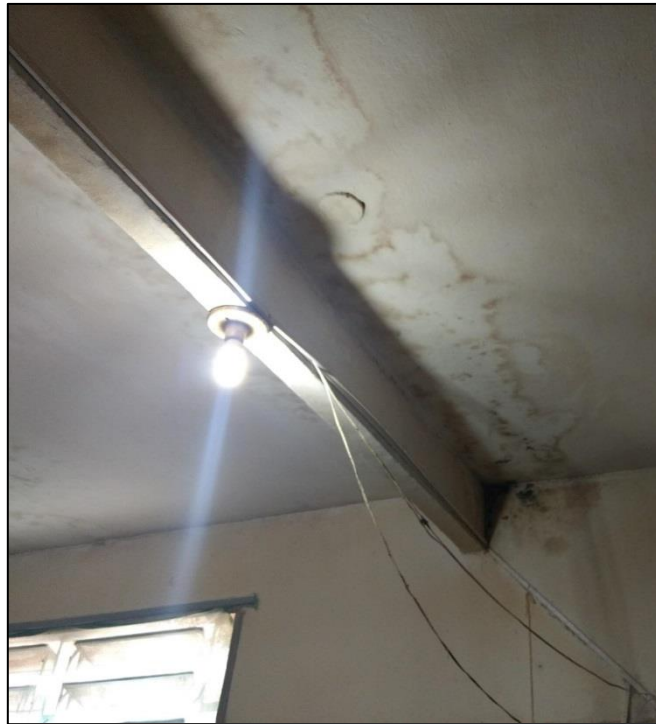
Figura 14: lâmpada sem proteção. Fonte: (Pinho, 2020).
