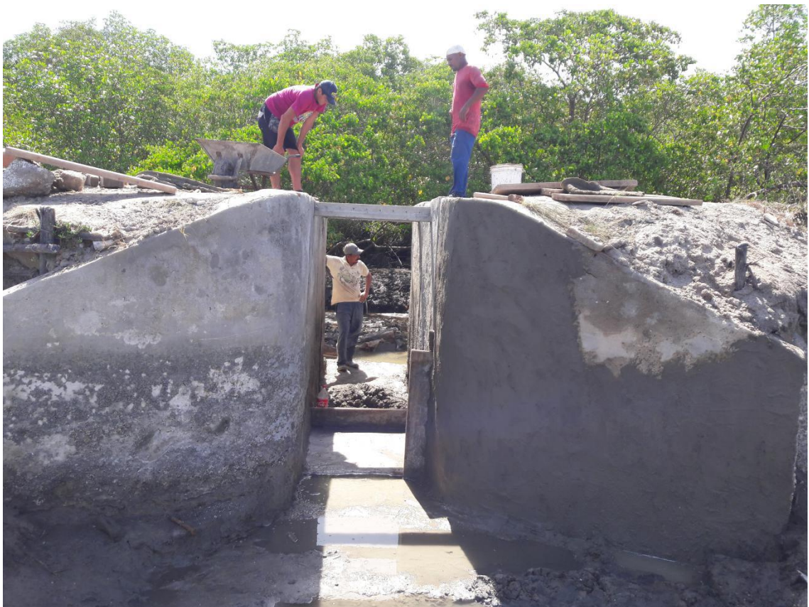
Figura 5 Vista interna da comporta sendo recuperada.
