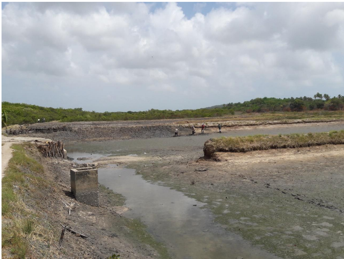
Figura 13 Dique de divisão rompido
