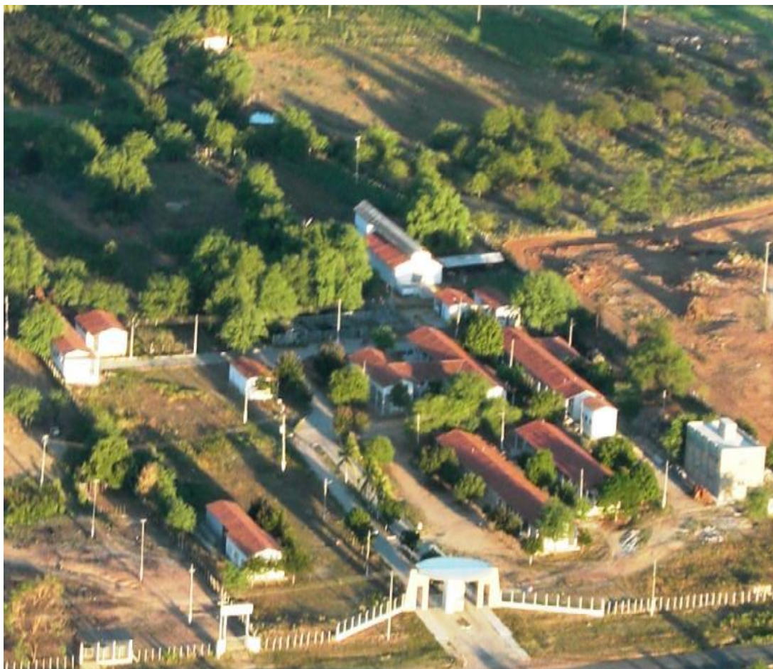
Figura 4. Vista aérea do Hospital Veterinário da Universidade Federal de Campina Grande, Campus Patos - Paraíba.
